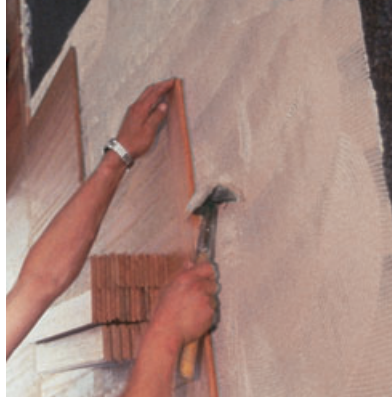
Bekleden van de vloer
